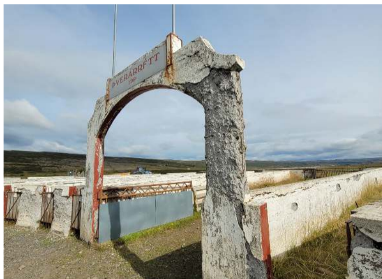
Veggirnir í Þverárrétt í Borgarfirði byrjuðu að brotna niður fljótlega eftir byggingu. Myndir / Aðsendar
